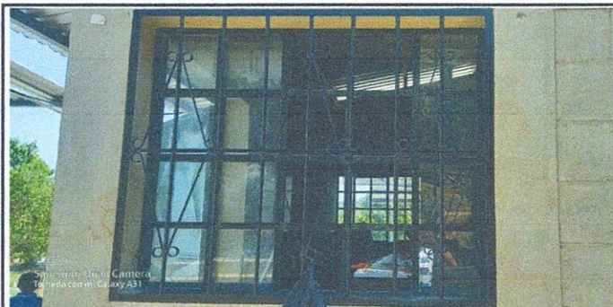
Foto 8: colocacion de balcon de la cocina del establecimiento
