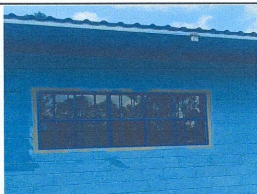
Foto 3: cambio de ventana, vidrios y colocacion de balcón, parte de enfrente del aula 4 y 5
