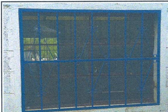
Foto 4: cambio de venta, vidrios y colocación de balcon parte atrás del aula 4 y 5
